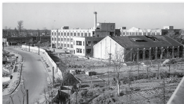
1945年（昭和20年）11月11日撮影 女子部屋上より見たる中学部校舎と講堂
