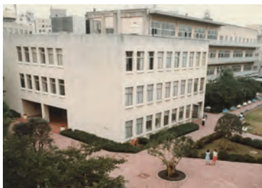
新本館 1966年竣工
