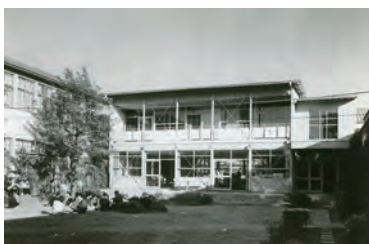
学生食堂 (学生ホール) 1960年竣工
