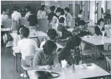
学生食堂（学生ホール）内部 1964年頃撮影
