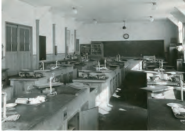
旧木造校舎内部
