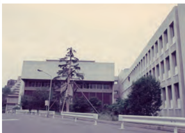
教育研究棟 (右) と図書館 (左) 1969年竣工
